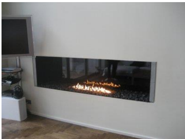
3. attēls. Gāzes kamīns 14
